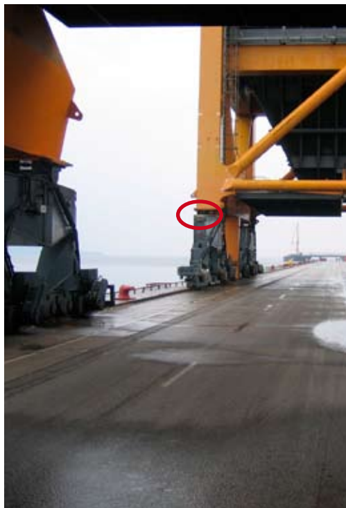
Laserscanneren på den ene kran
